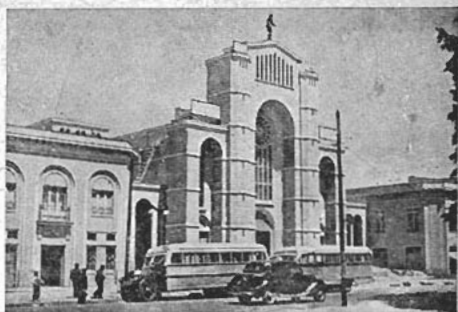
La moderna construcción de la Catedral de la ciudad
