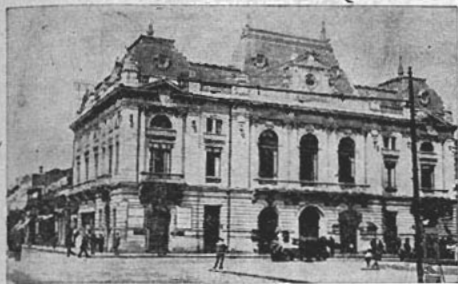
El edificio de la Municipalidad de Concepción
