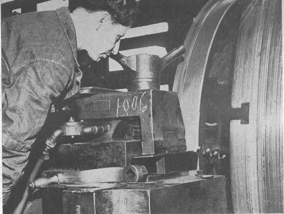
Taller de maquinarias. Puede verse a un obrero torneando una rueda de locomotora en un torno gigante.
