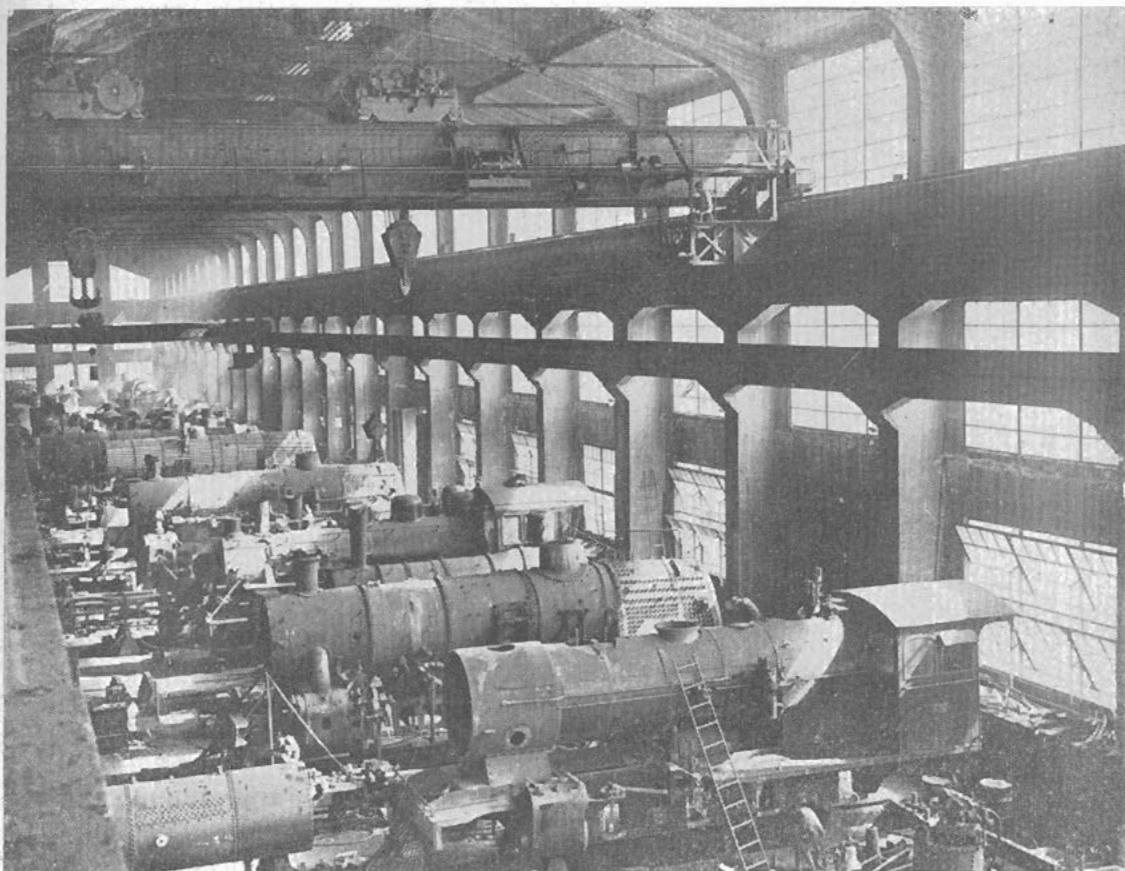
Taller de Armadura de la Maestranza. Obsérvese la grúa de 120.000 kilos accionada por un solo obrero.
