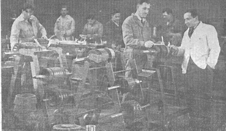
El taller eléctrico de la Maestranza, donde se construyen y reparan los dinamos y motores.
