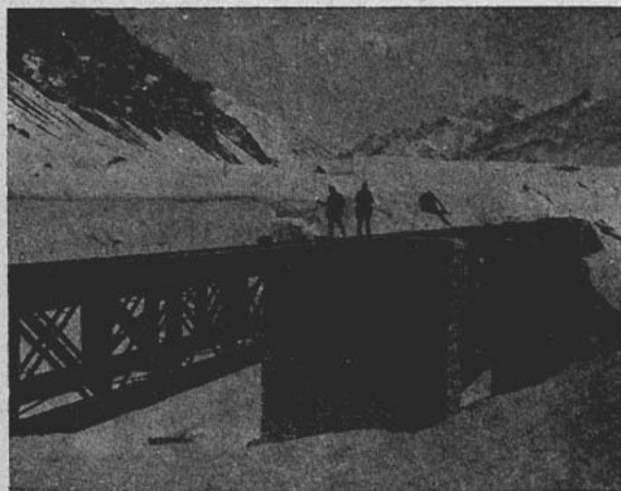
En el kilómetro 160 de la vía trasandina. El puente se vé rodeado por la nieve.
