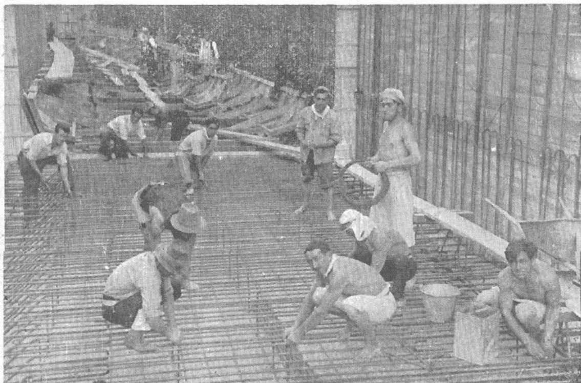
Faena de enfierradura en la losa inferior
